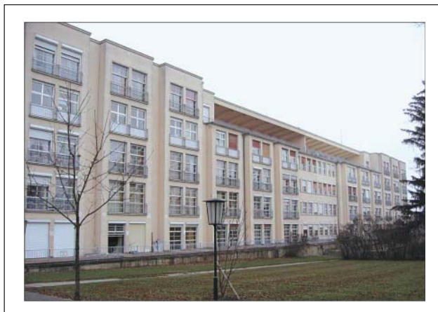
Krankenhaus Lainz, Pavillon VIII
