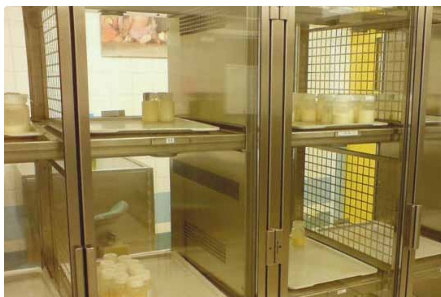
Milchküche 2010: Muttermilchdurchreicherkühlschrank. Die Muttermilch wird von den Angehörigen der Patienten vom Muttermilchabgaberaum aus im Durchreicherkühlschrank nunmehr stationsweise getrennt in den Fächern abgestellt. Leere sterile Einwegflaschen stehen vorgekühlt zur Entnahme für die Mütter bereit. Das Milchküchenpersonal entnimmt vom inneren Bereich der Milchküche die Muttermilch zur weiteren Verwendung bzw. Verwaltung.
